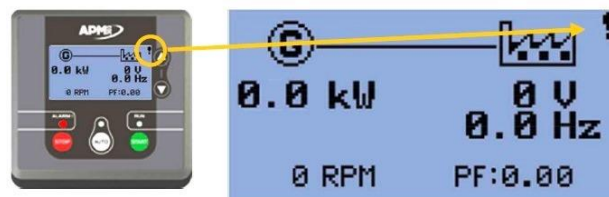
Aparición de una falla en el módulo APM303
