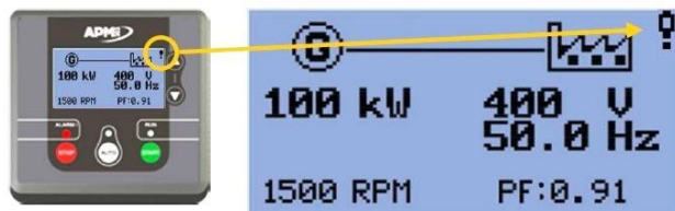
Aparición de una alarma en el módulo APM303
