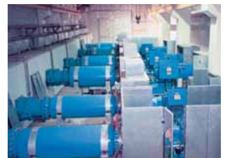
Suministro: HGF450, 630kW (845HP), 6.600V, 2 polos Aplicación: Sopladores
