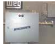
Sistema de presurización para área clasificada
