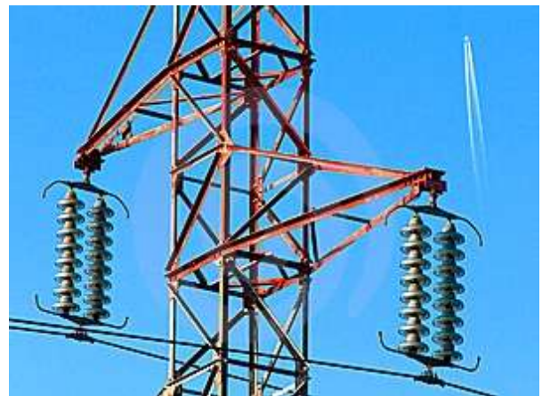
Cadena de suspensión con cuernos de descarga Figura 1
