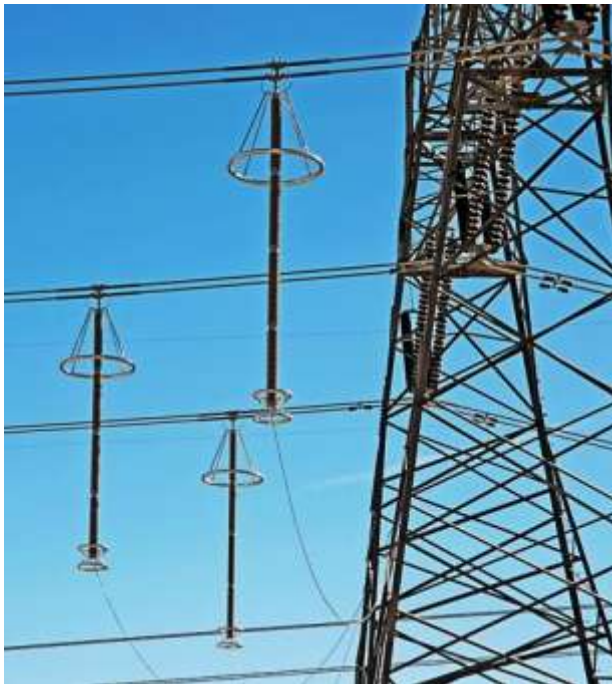
Figura 5. Descargador tipo NGLA
