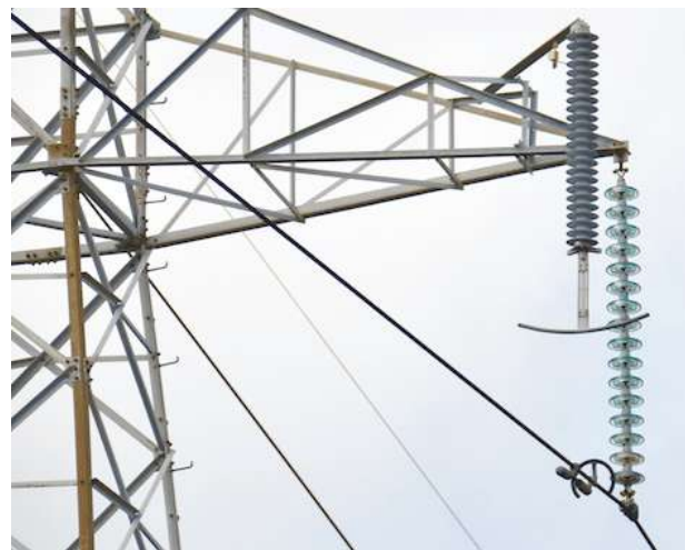
Figura 7. Descargador tipo EGLA
